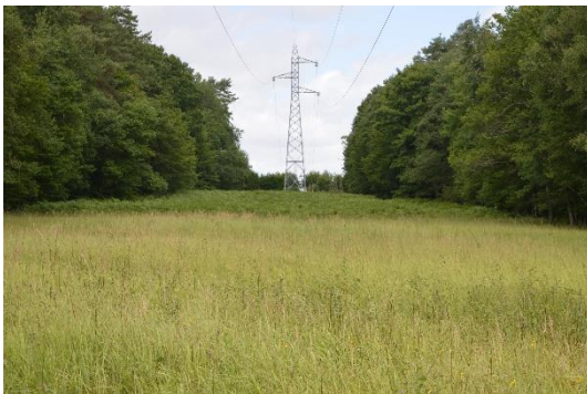
Tranchée forestière Photo : fdc10
