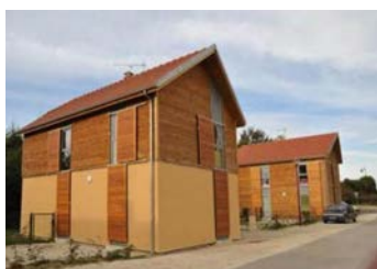
Figure 13 : Logements en ossature bois, béton de chanvre et bardage bois à Mesnil-Saint-Père (Source © : GAP, PnrFO).
