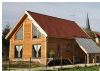
Figure 12 : Maison à ossature bois et bardage bois à Montreuil-sur-Barse (Source © : GAP, PnrFO).
