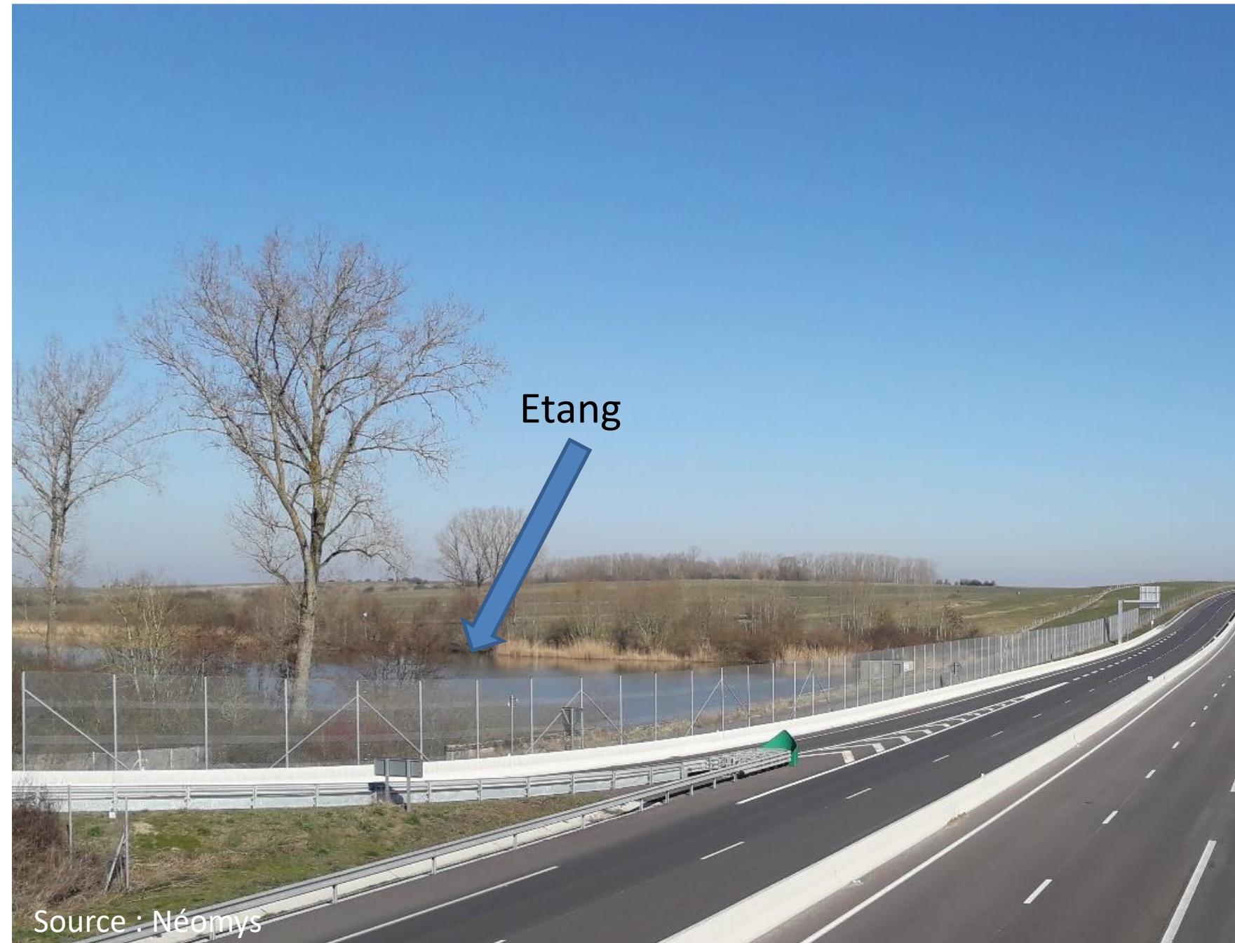
Parapet à chiroptères (lieu-dit neuf étang)
