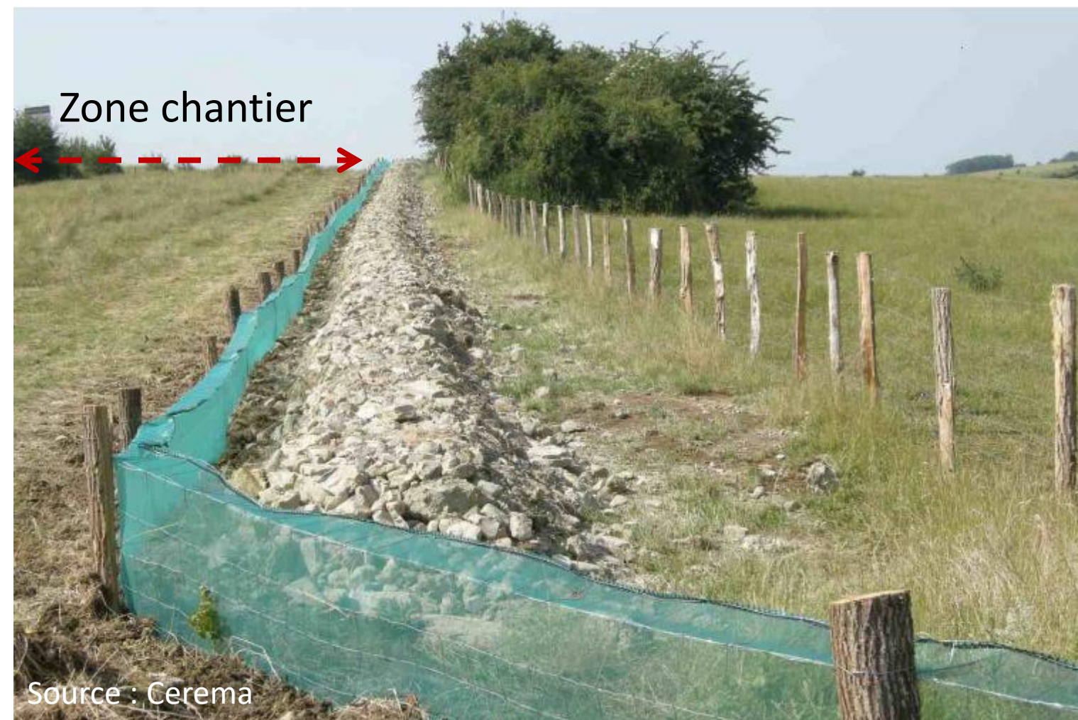
Pierrier en phase travaux (habitat de substitution hors du chantier)
